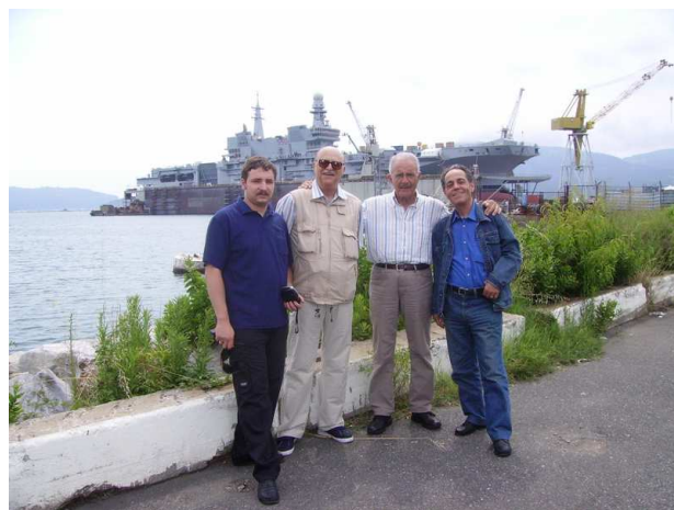
Il cantiere dove è in allestimento la Cavour
